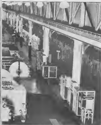
GENERADOR moderna, tal como esun banda di e vista interior aki di No. 1 Powerhouse, ta mas di milion dollar Americano cada uno. Un ta cambia forza di stien den forza eléctrico.
